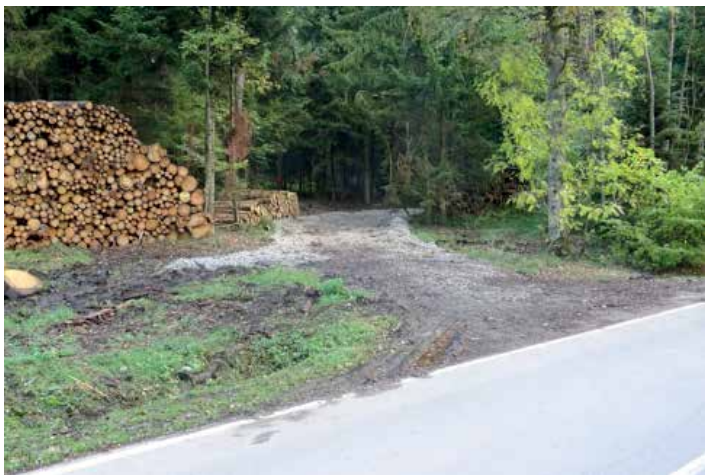
Eingebrachter Schotter 30-50, 4,5 m breit, links und rechts Lagerplätze
